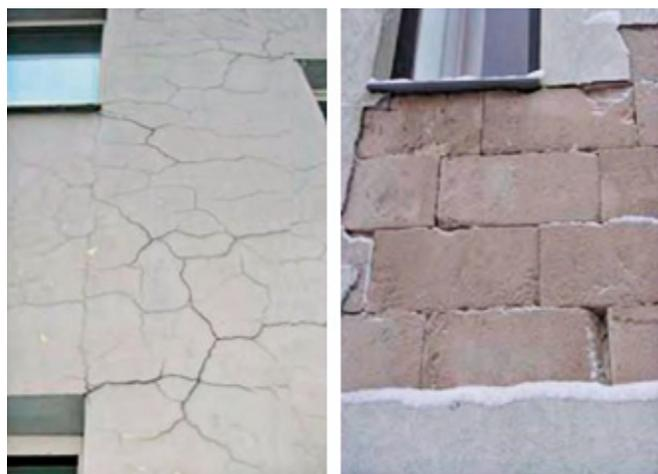
Рис. 12. Разрушение и отслоение штукатурного покрытия от газобетонной кладки [23].
